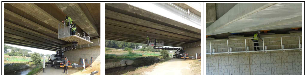
[고소작업차를 이용한 근접조사 실시]
